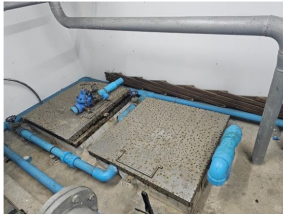
รูปที่ 2-19 ถังสำรองน้ำใต้ดิน
